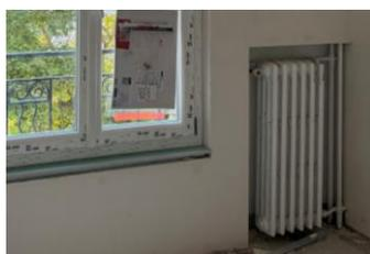
Les travaux ont été réalisés pendant la période de chauffe, la dépose des émetteurs était donc impossible. L'isolation derrière les émetteurs s'effectuera dans un second temps afin d'assurer une continuité d'isolant et éviter les ponts thermiques.
