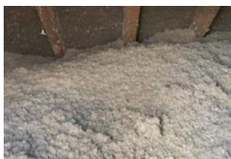
La fibre de bois et la ouate de cellulose soufflée ont été utilisés en toiture pour répondre à une problématique de confort. Le temps de déphasage élevé de ses matériaux permet en effet de ralentir la progression de la chaleur et donc d'améliorer le confort d'été.
